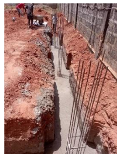
Aushebung und Bau des Fundaments, ein Kraftakt mit unzähligen Säcken Zement
