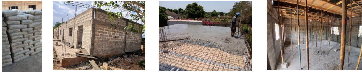
Arbeiten seit Januar 2026: Bau der Wände, Unterbau für Betondach, Betonieren der Decke
